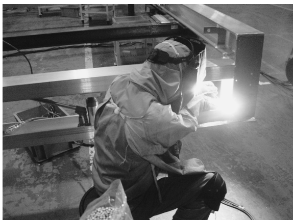
上覆蓋を支えるフレーム材の狭隘部をすみ肉溶接する まよう
