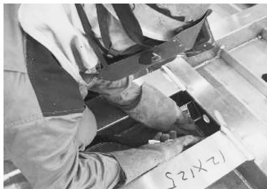
死角が発生する狭所の溶接では 小さな鏡を活用する工夫も
