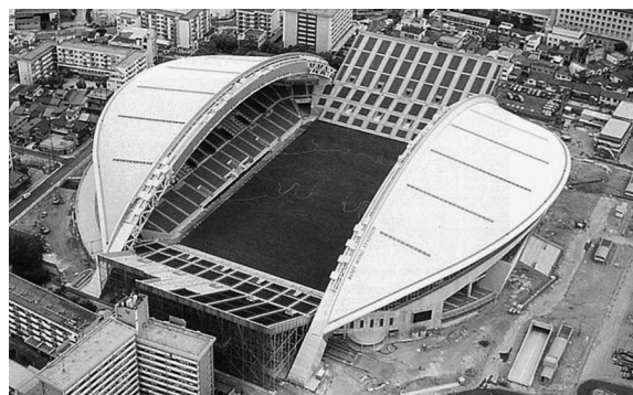
Fig. 19 開閉屋根（神戸ウイングスタジアム）
