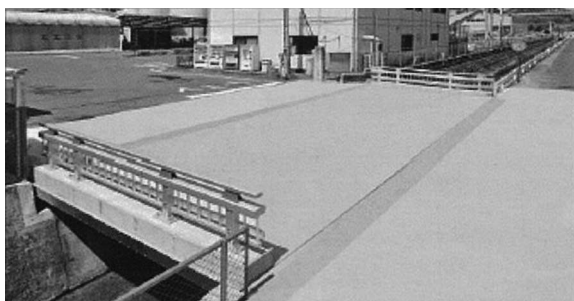
Fig. 16 アルミニウム床版道路橋
