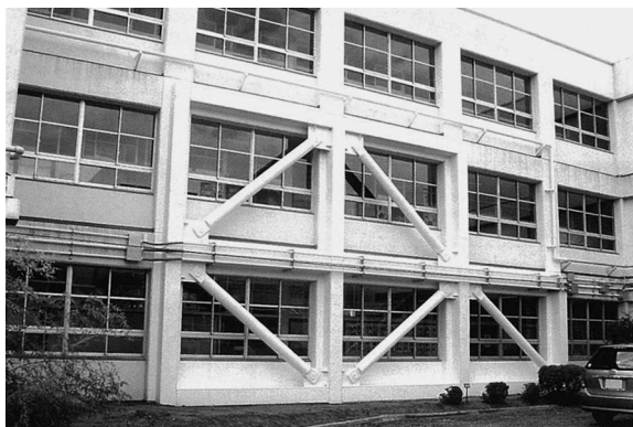
Fig. 21 耐震ブレース
