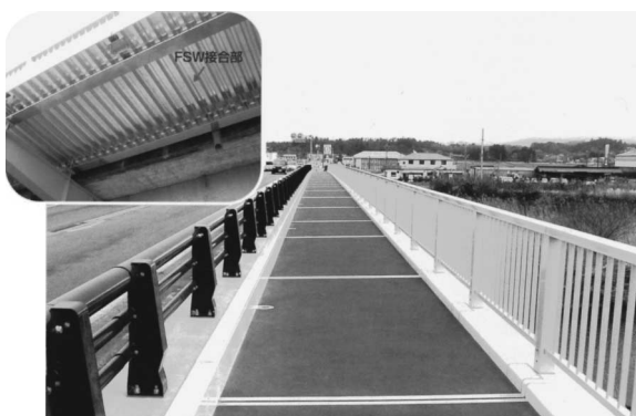
Fig. 15 拡幅歩道橋（秋田県小高川橋）
