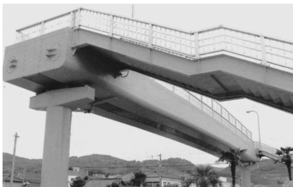
Fig. 14 跨線橋（長崎県川棚駅）
