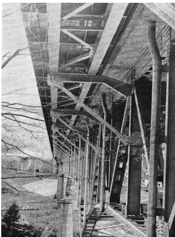
Fig. 10 アルミニウム床版を用いた大月橋拡幅歩道
