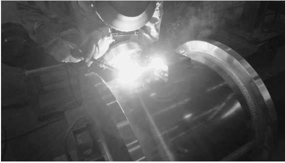
アルミニウムタンクのMIG溶接作業①
