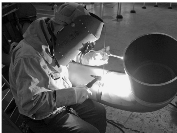
Fig. 3 左手にアルミ溶接棒4本を握り、円周をノンストップで2層盛溶接
