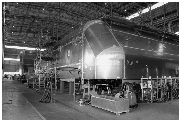
Fig. 2 アルミ SPB タンク完成間近の下部ブロック (写真手前) と上部ブロック
