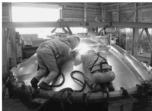
写真2 基幹技術である溶接条件ノウハウを駆使し、熱による歪みを最小限に抑えたTIG溶接を行う
