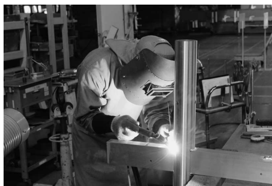
写真2 幟ポールの溶接施工の様子
