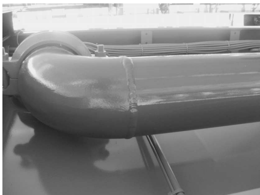
写真3 配管溶接部
