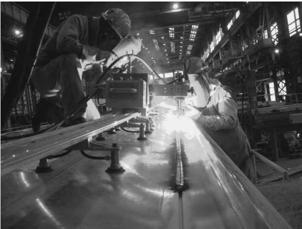
Fig. 2 溶接作業のようす
