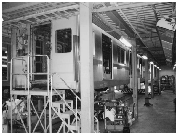
Fig. 1 東京メトロ・半蔵門線のリニューアル工事
