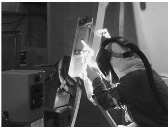
Fig. 2 ティグ溶接状況
